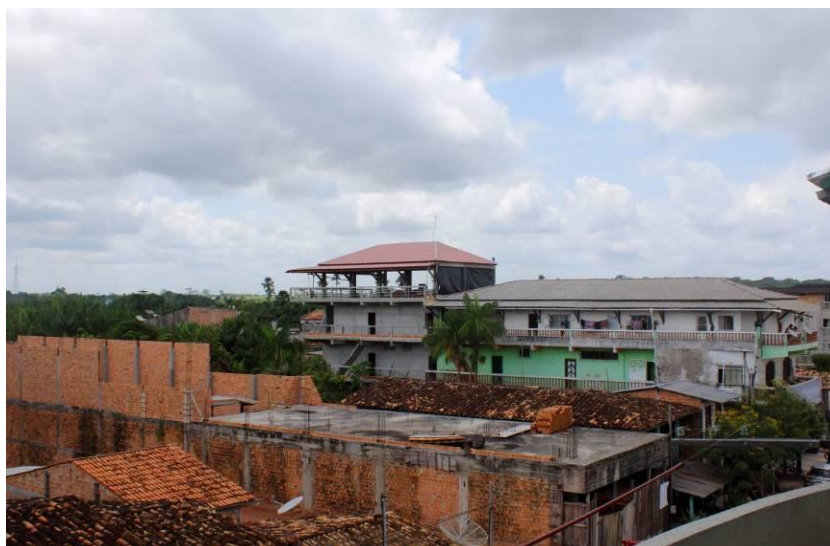
Foto 12 - Obras na área central de Acará
